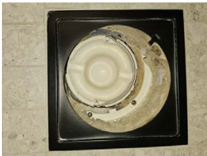
Bilde viser sluk på bad.
