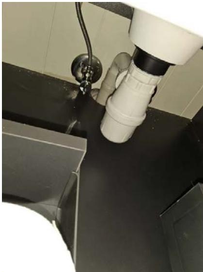
Bilde viser avløpsrør på toalettrom.
