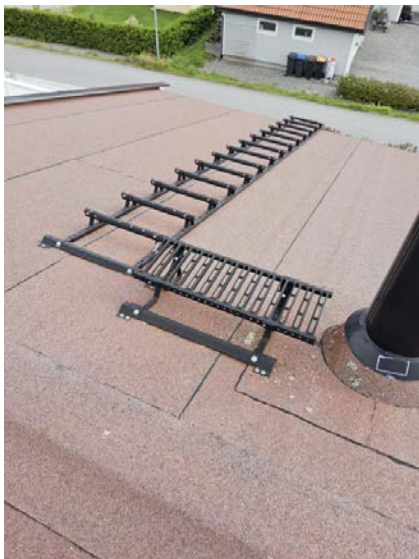
Bilde viser takstige.
