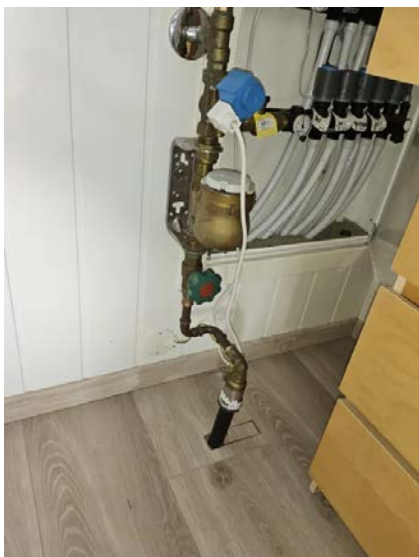
Bilde viser hovedstoppekran.
