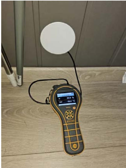
Bilde viser fuktmåling på bad.
