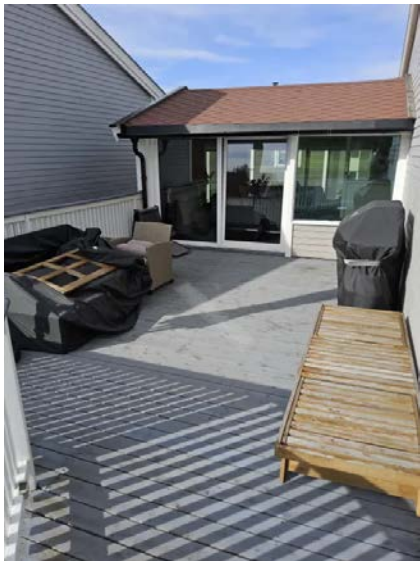
Bilde viser del av balkong.
