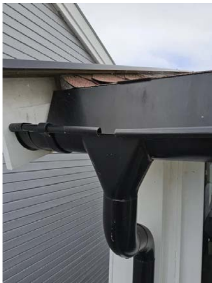
Bilde viser overgang mellom takrenne og taknedløp på vinterhage.
