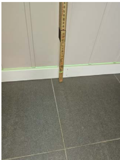
Bilde viser måling av etasjeskiller.
