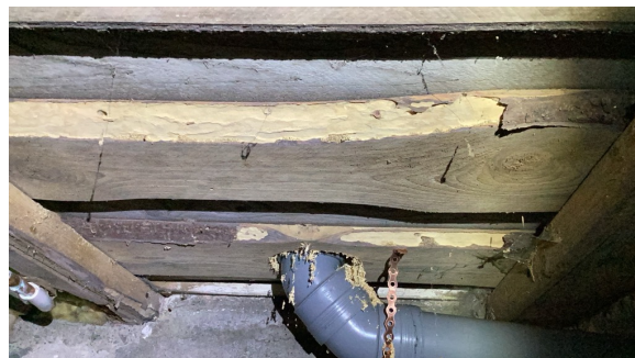
Spor etter treskadeinsekter.
