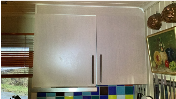
Skapdør trenger justering.
