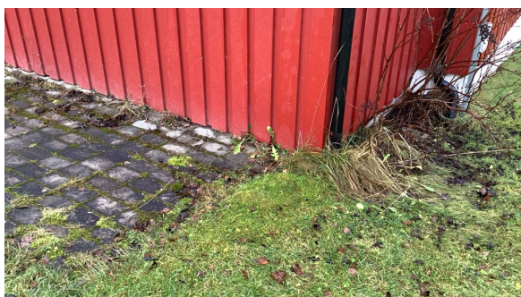
Lav høyde mellom kledning og terreng øker risikoen for skader.
