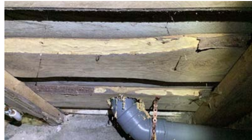
Spor etter treskadeinsekter.
