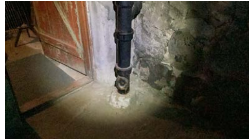
Stakeluke på bod.
