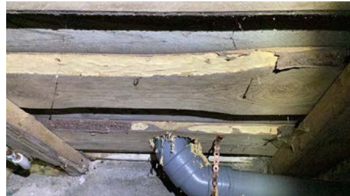
Spor etter treskadeinsekter.
