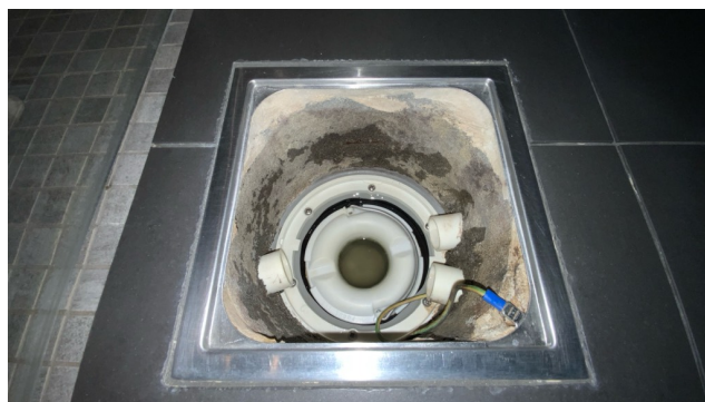
Kontroll av sluk.
