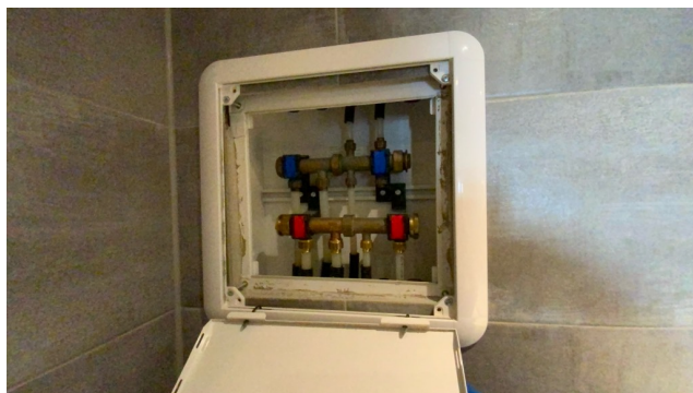
Besiktigelse av røropplegg.
