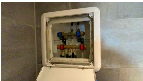
Besiktigelse av røropplegg.
