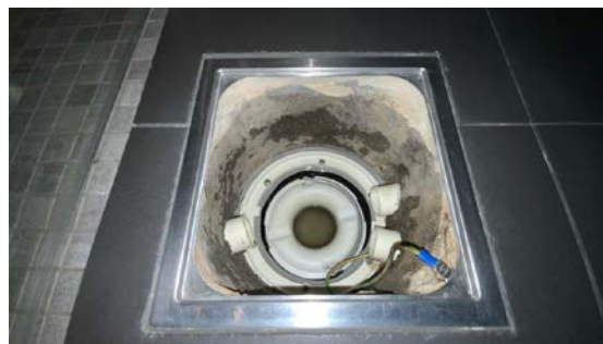
Kontroll av sluk.
