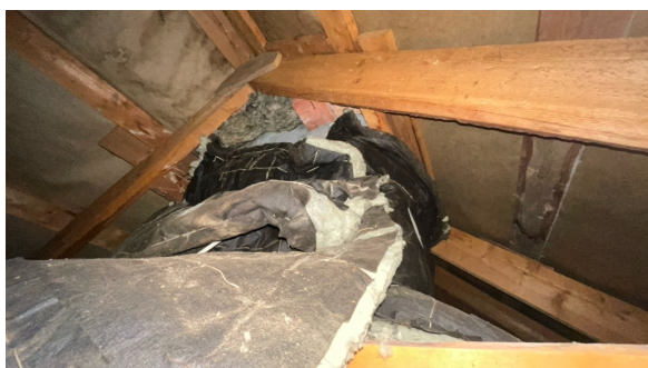
Pipevanger tildekket på kryploft.
