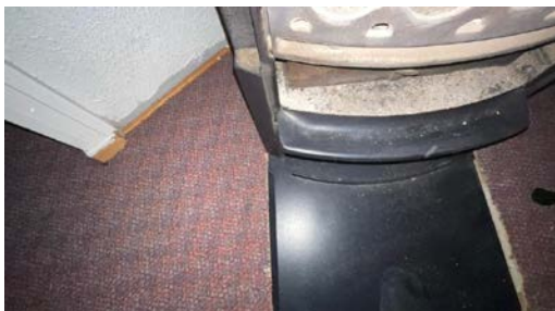
Kort avstand fra ovnsdør til brennbart materiale i kjeller
