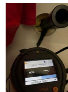
Måleresultat med pigger i treverk. Stort bad 2.etg.
