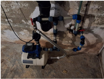
Vannpumpe arbeider mye grunnet lekkasje på vannrør
