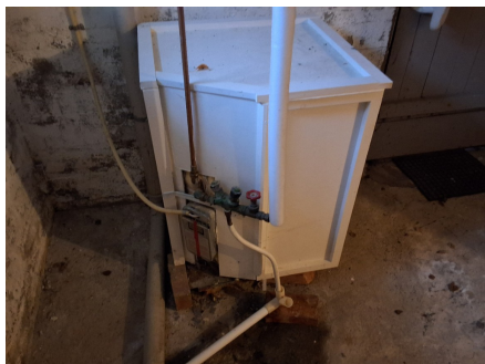
Varmtvannbereder er innebygget
