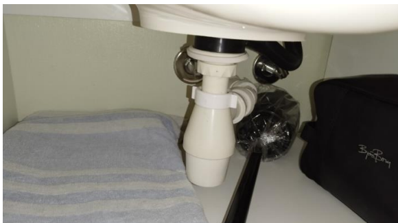
Kontroll av røropplegget.
