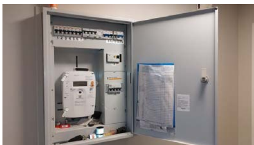
Kontroll av sikringskapet.
