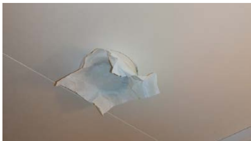
Test av avtrekket.
