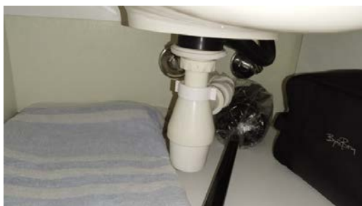
Kontroll av røropplegget.
