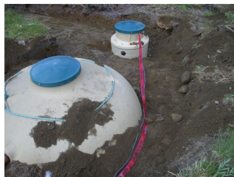
Bilde fra byggeplassen.
