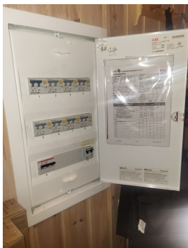
Sikringsskap med automatsikringer.
