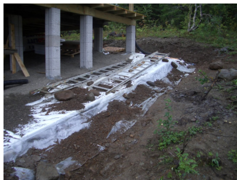
Bilde av fundamentering under byggeperioden.
