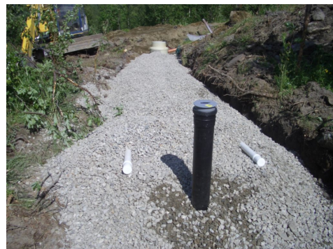
Spredegrøft med rør.
