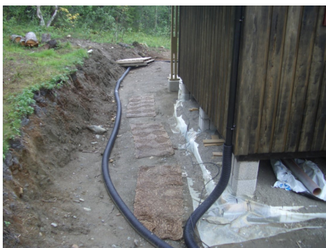
Bilde av montering av drenering under bygging.
