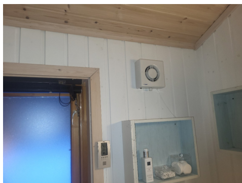
Mekanisk avtrekk.
