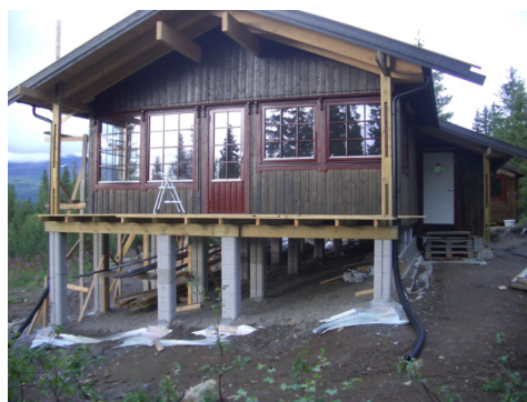
Bilde av fundamentering under byggeperioden.
