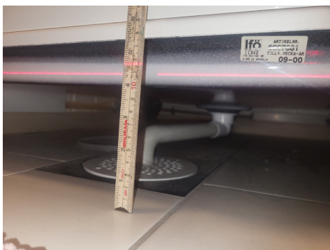
Måling av fall til sluk.
