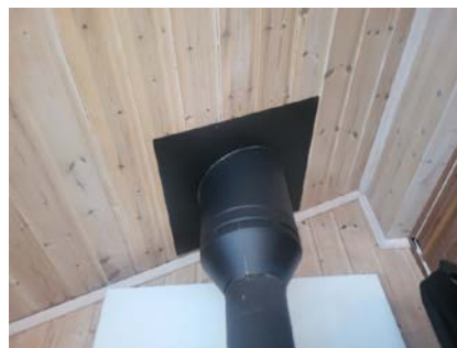
Tetting mot tak.
