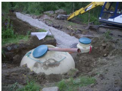
Septiktank, pumpekumme og spredegrøft.
