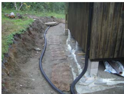
Bilde av montering av drenering under bygging.
