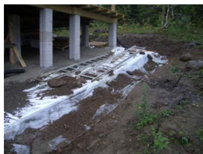
Bilde av fundamentering under byggeperioden.
