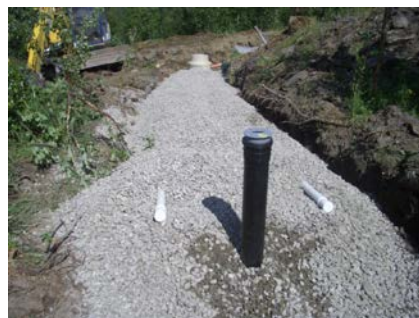
Spredegrøft med rør.
