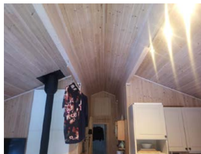
Lukket takkonstruksjon.
