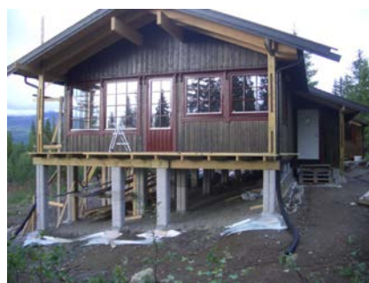
Bilde av fundamentering under byggeperioden.
