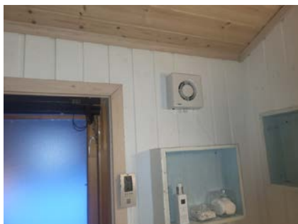
Mekanisk avtrekk.
