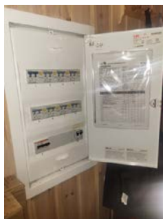
Sikringsskap med automatsikringer.
