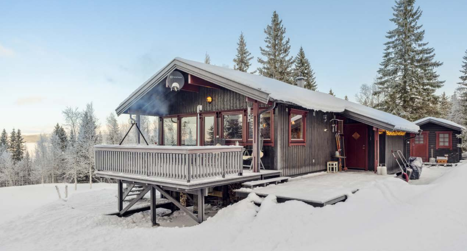
Terrassen er fundamentert på leca søyleblokker.
