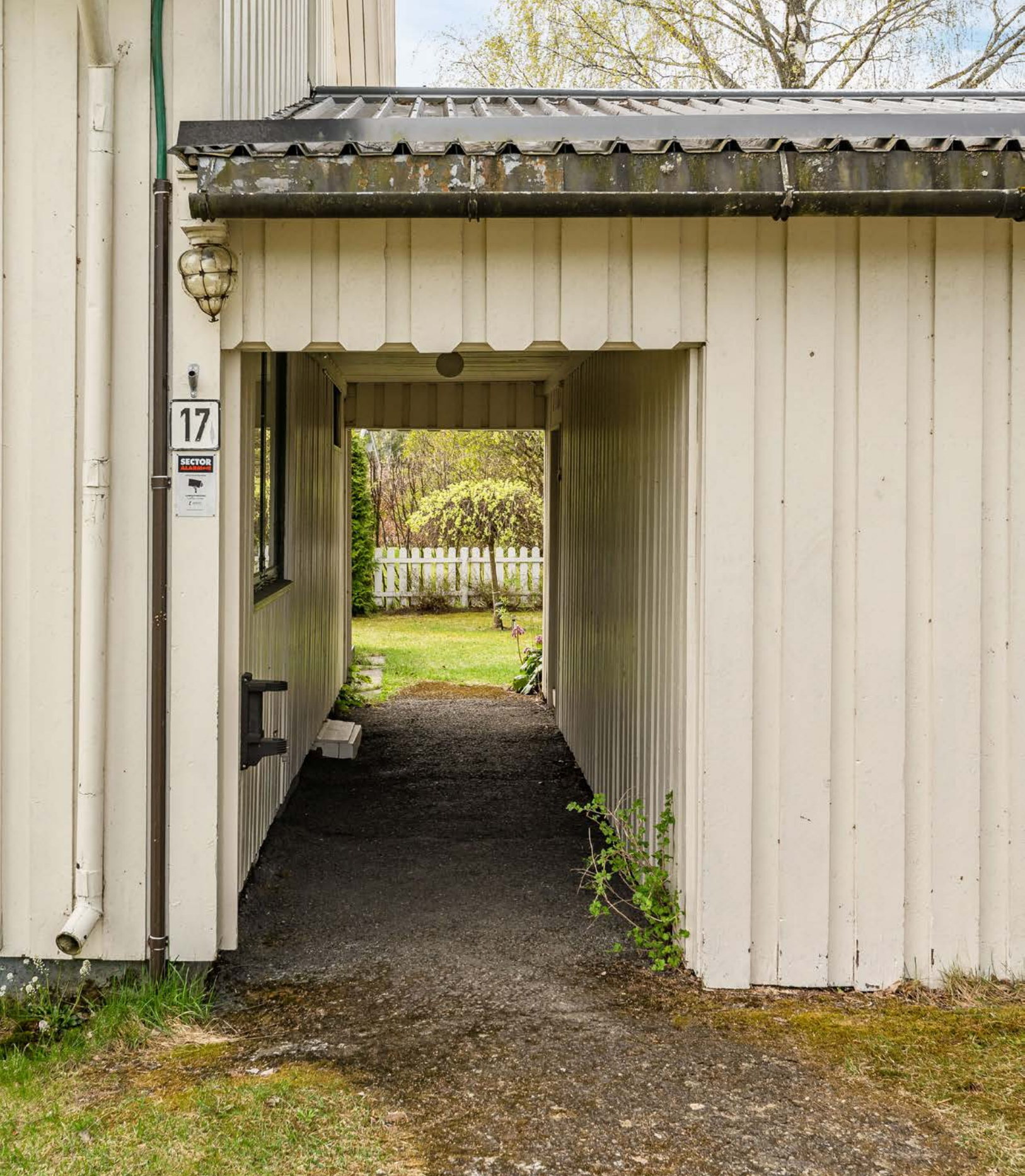
Takoverbygd gangvei mellom boligen og garasjen.
