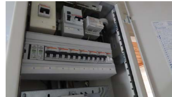
Sikringssskap.
