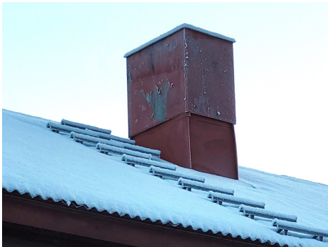
Rust på pipebeslag.
