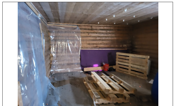
Innvendig del av tømring i uthuset.
