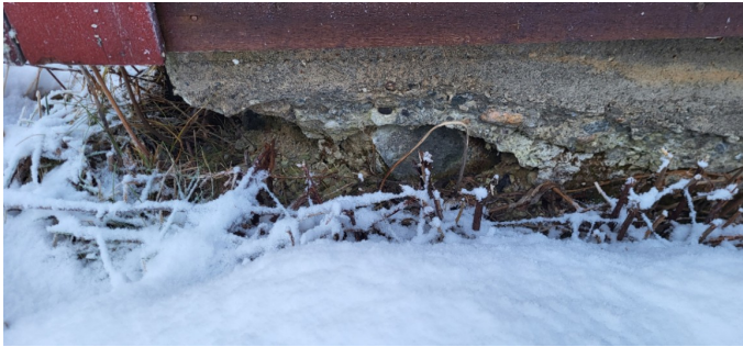
Grunnmur delvis bortvitret
