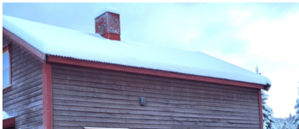
Rust på pipebeslag.
