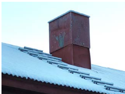
Rust på pipebeslag.
