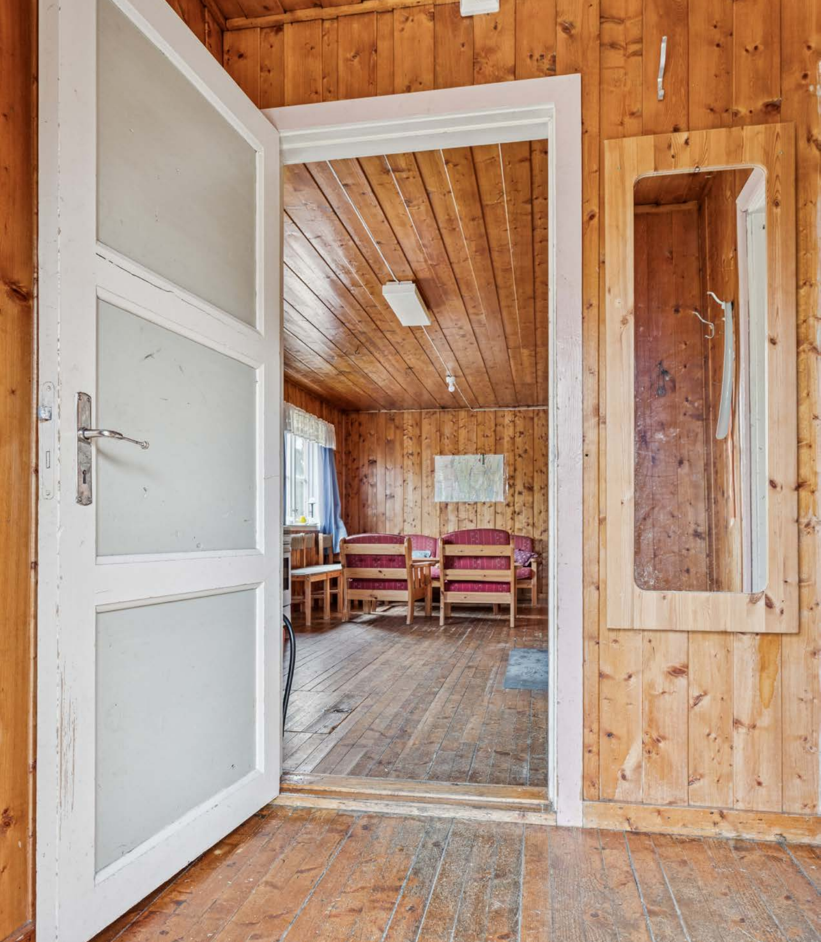
Innvendige overflater i gangen har trepanel på vegger og tak, samt gulv av furu med synlig slitasje.
