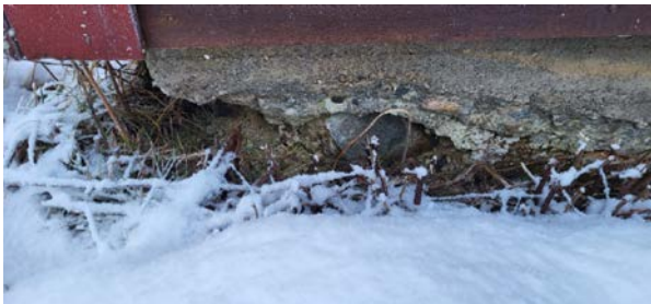
Grunnmur delvis bortvitret
