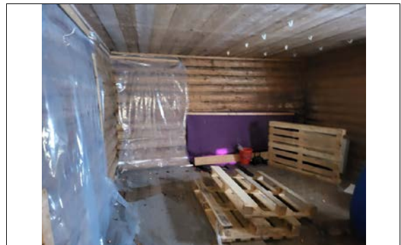
Innvendig del av tømring i uthuset.
