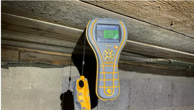
Ved fuktmåletaking av stubbeloft var det normal fuktnivå under beforing
