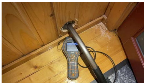
Hulltaking er foretatt fra vindfang, ved fuktmåletaking var det ikke fuktsutslag
