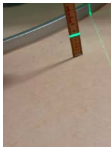
Fuget gulvskinne som danner en sperre mot sluk.
