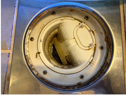
Plastsluk uten tegn på skader
