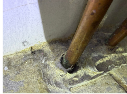
Kun fuget med silikon og stedvis åpninger
