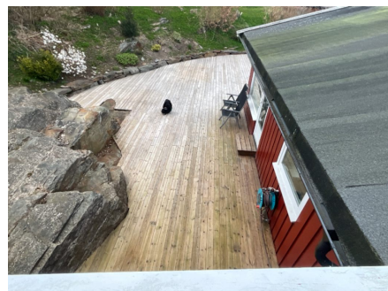
Stort vannpress fra terrennet.
