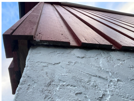
Ny kledning på fronten.
