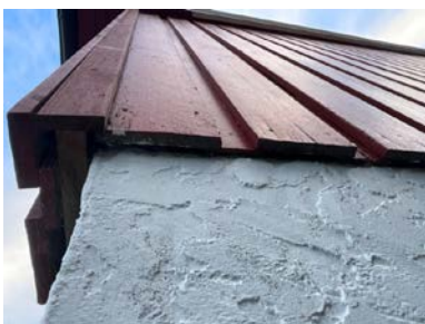
Ny kledning på fronten.
