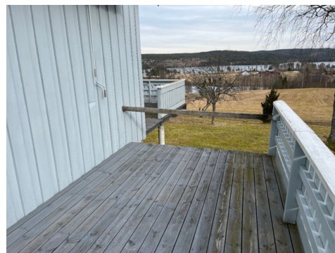
Terrasse med provisorisk sikring.
