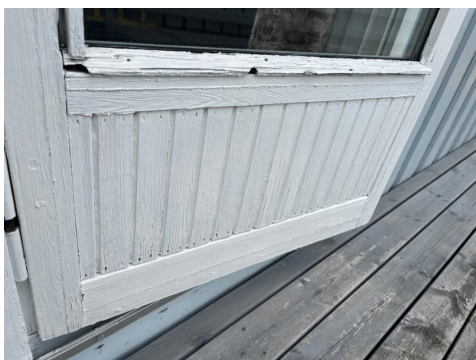
Terrassedør med skader utvendig.
