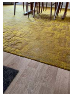
Nedslitte vegg-til-vegg tepper.
