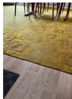
Nedslitte vegg-til-vegg tepper.
