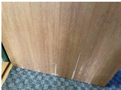
Dør med skadet finer.
