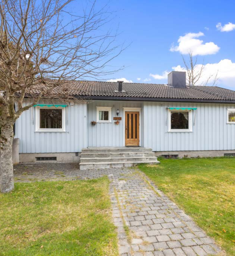
Boligen ble oppført i 1971 og holder en eldre standard - slik at modernisering bør påregnes.
