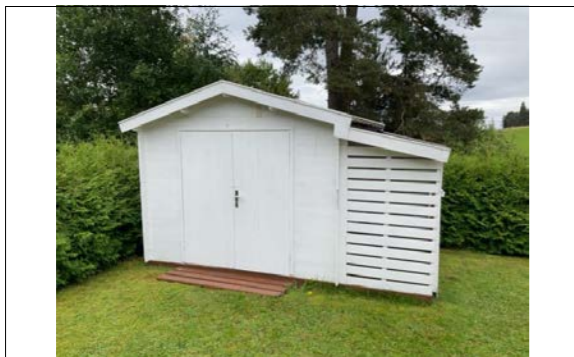
Hagebod ca. 5,5m 2 på eiendommen. Hageboden er oppført i enkel trekonstruksjon med laftet plank.
