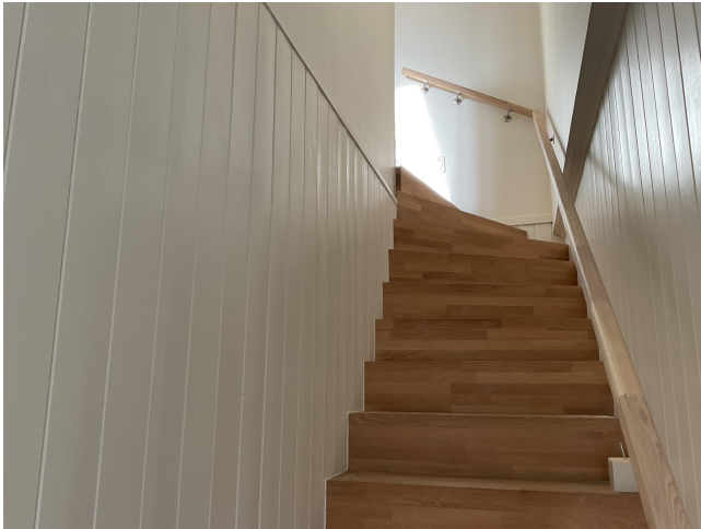
Håndløper på en side i trappeløp.
