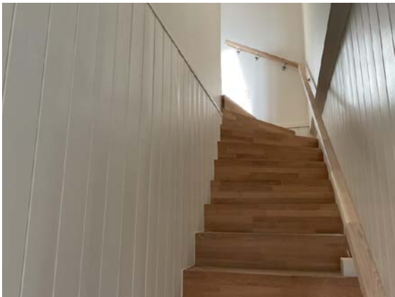
Håndløper på en side i trappeløp.
