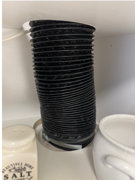
Avtreksrør i skapet er uten skader.
