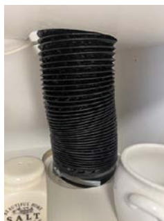
Avtrekkørør i skapet er uten skader.
