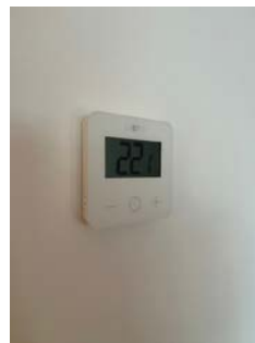
Betjeningspanel til vannbåren varme
