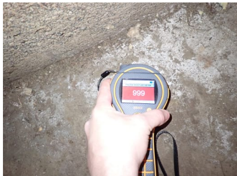
Fuktmåling på gulv.
