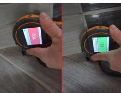
Måling foretatt i samme område. Viser plutselig fuktutslag.
