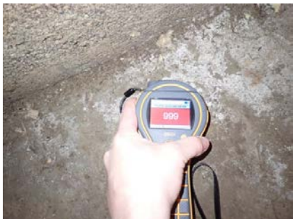
Fuktmåling på gulv.
