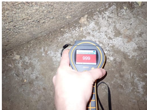
Fuktmåling på gulv.
