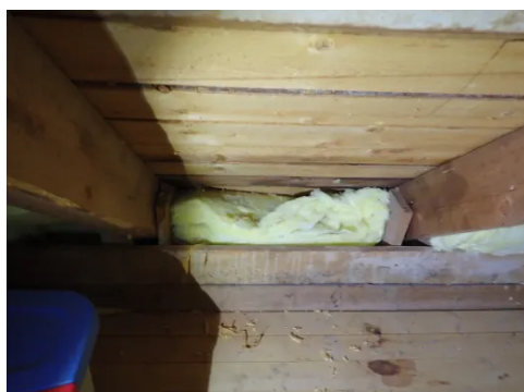
Begrenset/dårlig lufting ved raft.
