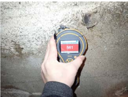
Fuktmåling oppe på vegg på grunnmur.
