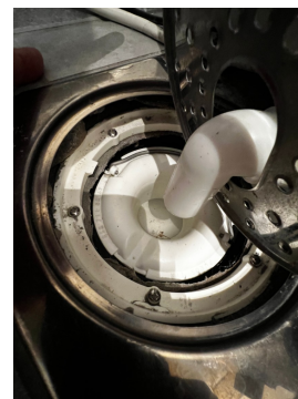
Membran synlig under klemring i sluk
