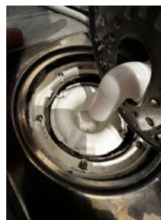
Membran synlig under klemring i sluk
