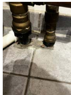
Membran synlig under klemring i sluk
