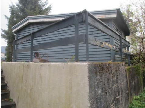
Støpt forstøtningsmur i mot garasje.
