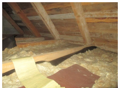
Deler av undertaket.
