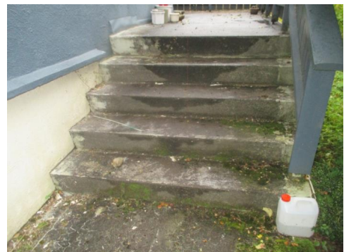
Støpt trapp til terrasse.
