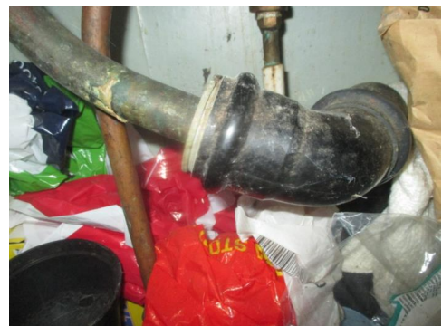
Eldre avløpsrør i kjøkkenbenken.
