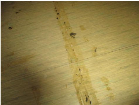
Slitt/skadet gulvbelegg.
