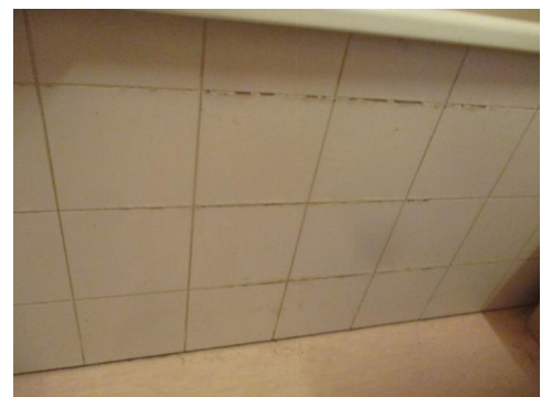
Badekar er blitt bygget inne.
