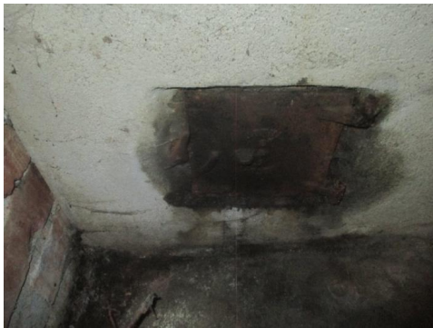
Sotluke i grovkjeller.
