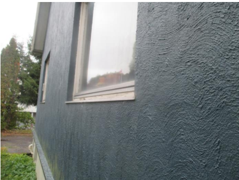
Deler av murfasade.
