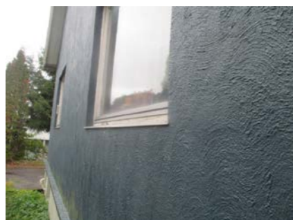
Deler av murfasade.
