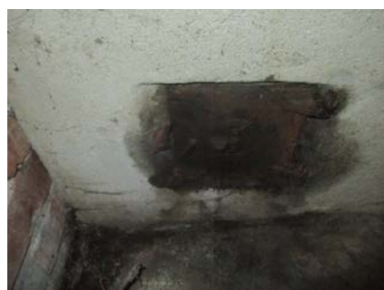
Sotluke i grovkjeller.
