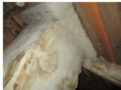
Gjennomføring av pipe.
