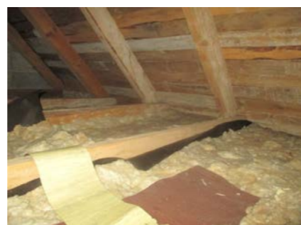
Deler av undertaket.
