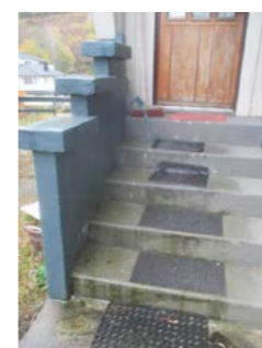
Støpt trapp ved inngangsparti.
