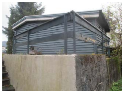
Støpt forstøtningsmur i mot garasje.
