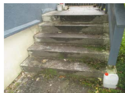
Støpt trapp til terrasse.
