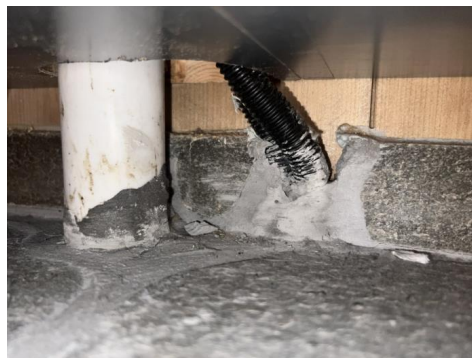
Fra sluk ble det registrert tettesjikt under klemring
