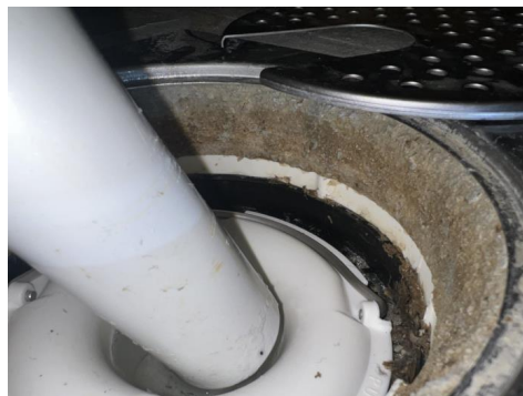
Fra sluk ble det registrert tettesjikt under klemring
