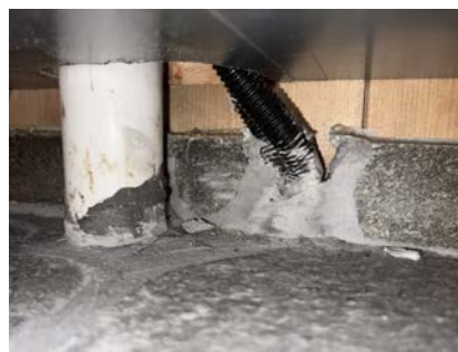
Fra sluk ble det registrert tettesjikt under klemring
