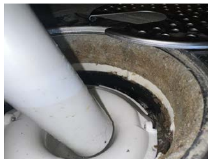
Fra sluk ble det registrert tettesjikt under klemring
