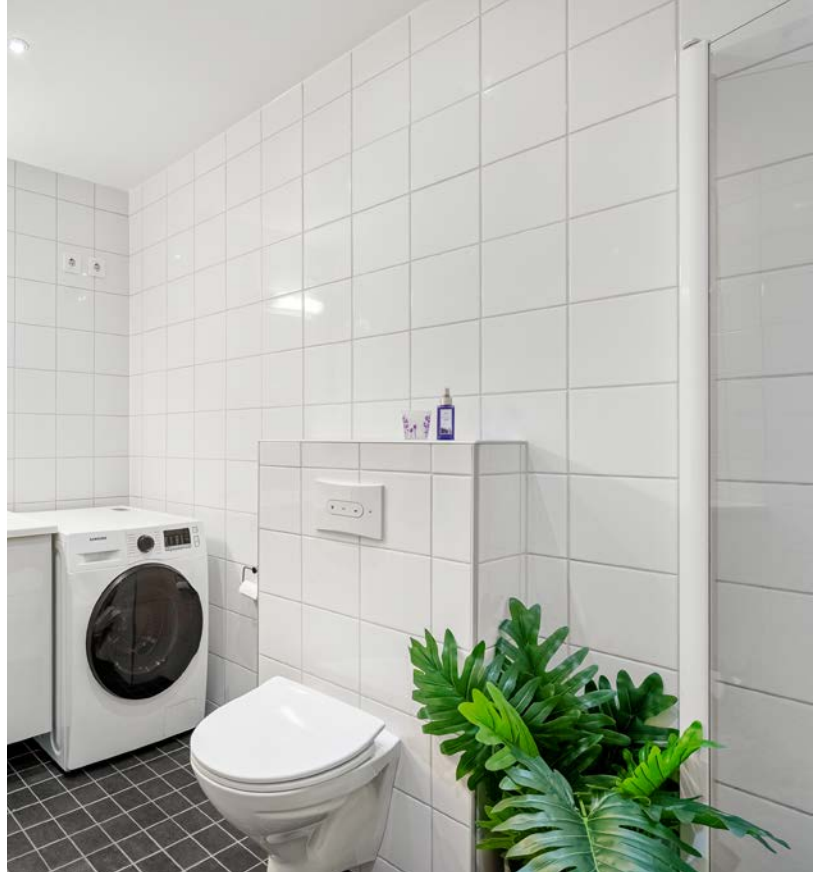
Fliser på gulv og vegg.
