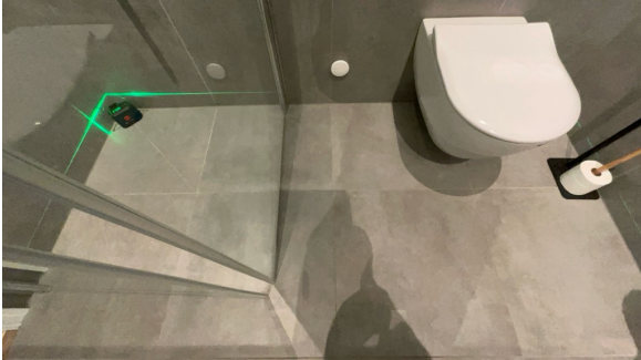
Målt fall på gulv. Del av gulv.
