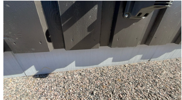
Del av grunnmur - støpt plate på mark.
