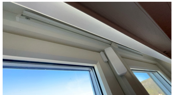
Eksempel på montert ventil i vindu.
