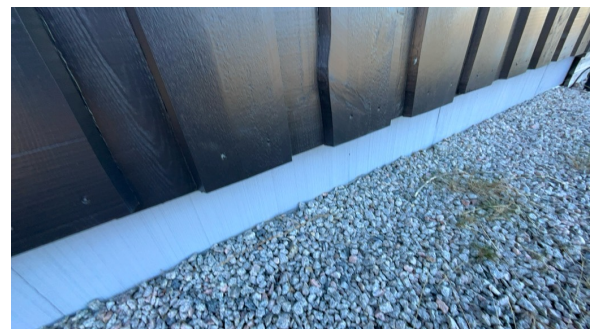
Del av grunnmur - støpt plate på mark.
