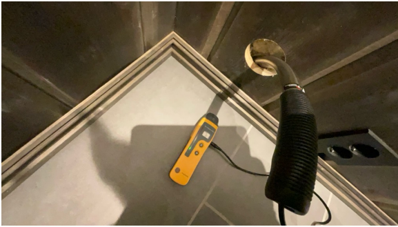
Hull for kontroll av fukt.
