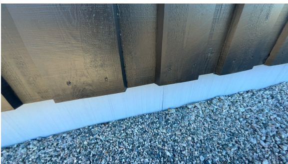
Del av grunnmur - støpt plate på mark.
