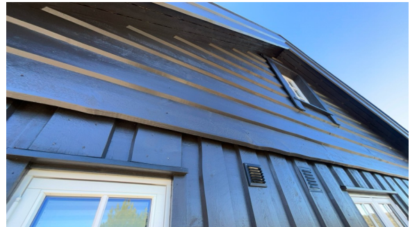
Del av vegg.
