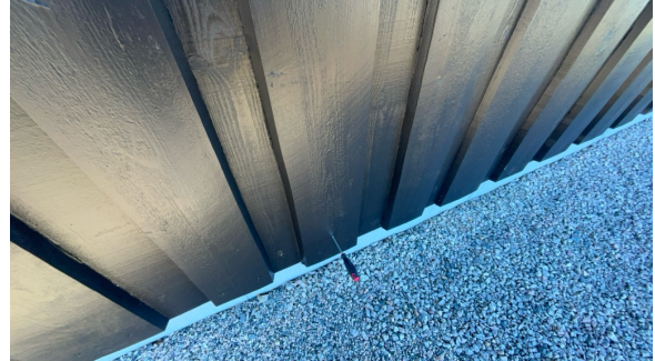
Stikk kontroll av vegger er utført. Del av vegg.
