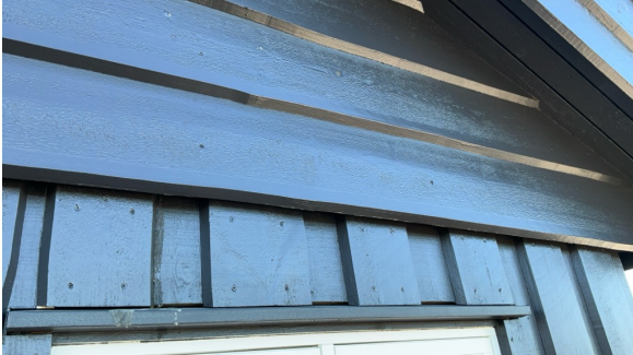
Del av vegg.
