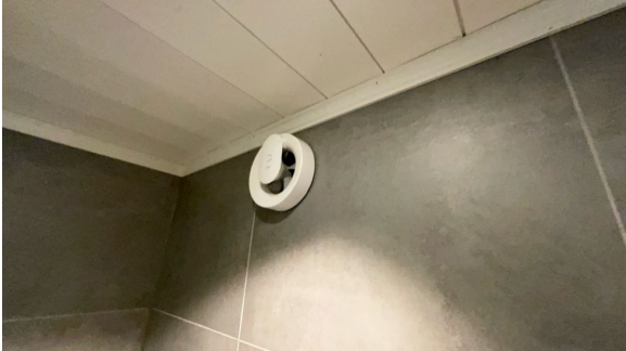
Montert avtrekk i vegg.
