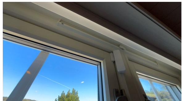
Eksempel på montert ventil i vindu.
