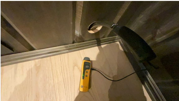
Hull for kontroll av fukt.
