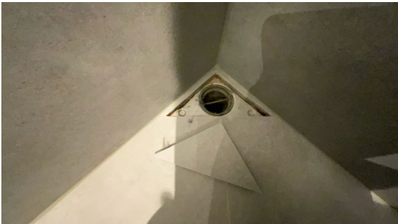
Sluk i gulv.
