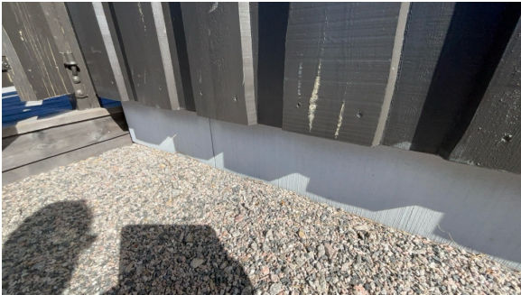
Del av grunnmur - støpt plate på mark.
