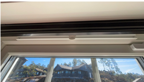
Eksempel på montert ventil i vindu.
