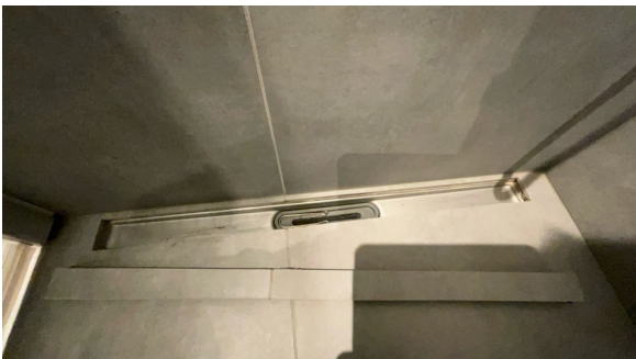
Sluk i gulv.
