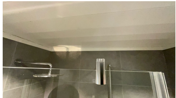
Del av vegg - tak.
