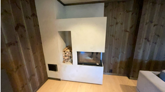
Montert peis med innsats.
