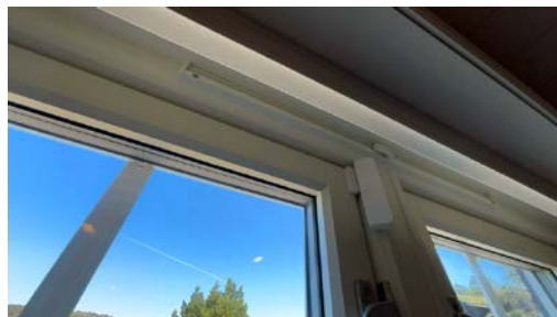
Eksempel på montert ventil i vindu.
