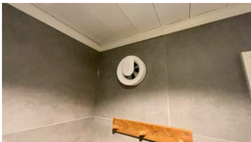
Montert avtrekk i vegg.
