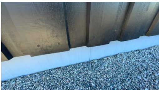
Del av grunnmur - støpt plate på mark.
