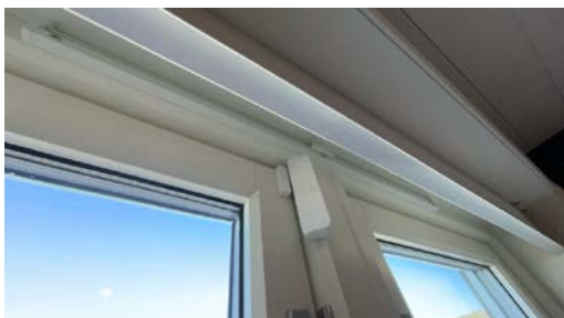
Eksempel på montert ventil i vindu.
