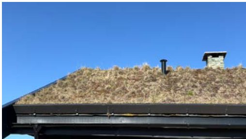
Del av taktekkning.
