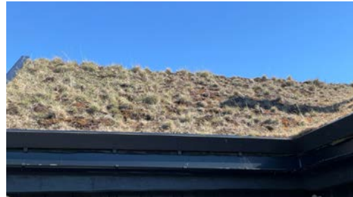
Del av taktekkning.
