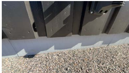
Del av grunnmur - støpt plate på mark.
