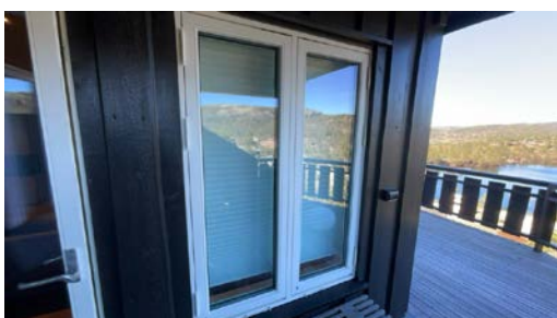
Eksempel på vindu i yttervegg.
