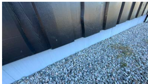
Del av grunnmur - støpt plate på mark.
