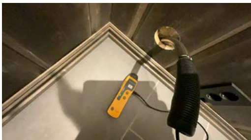
Hull for kontroll av fukt.
