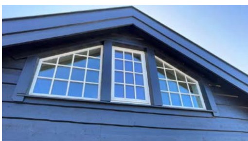
Eksempel på vindu i yttervegg.
