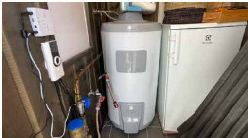
Varmtvannstank.
