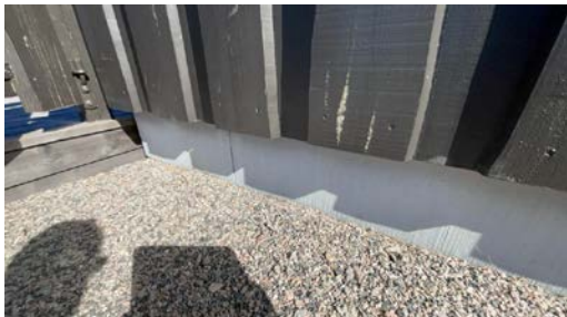
Del av grunnmur - støpt plate på mark.
