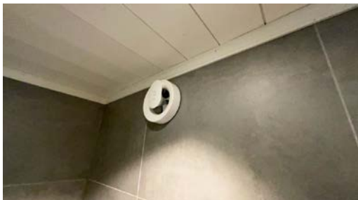
Montert avtrekk i vegg.
