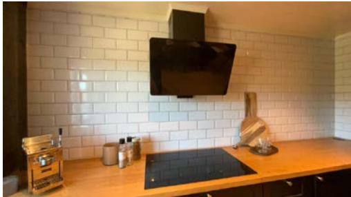
Montert avtrekk over steketopp.
