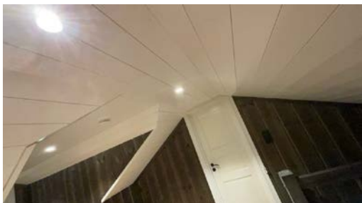
Del av takkonstruksjon, sett fra 2 etasje.
