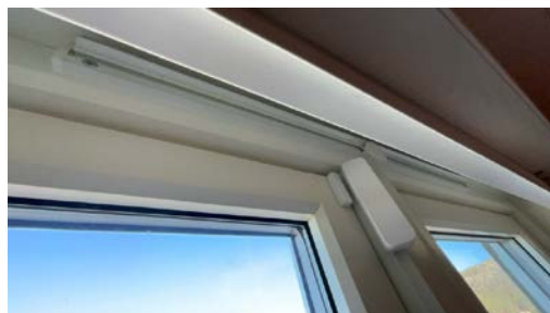
Eksempel på montert ventil i vindu.
