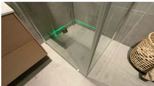
Målt fall på gulv.
