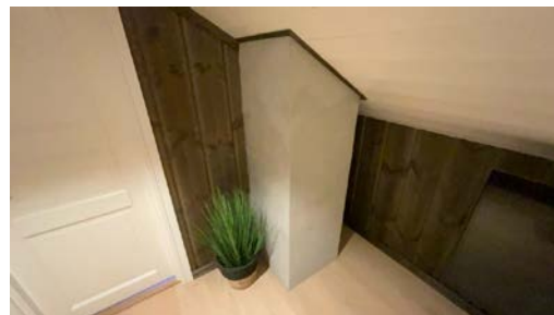
Del av pipe.
