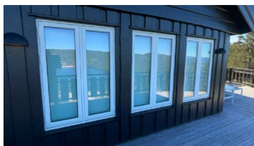
Eksempel på vindu i yttervegg.
