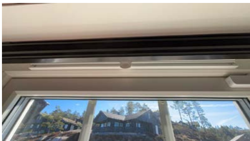
Eksempel på montert ventil i vindu.
