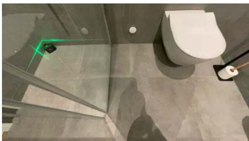
Målt fall på gulv. Del av gulv.
