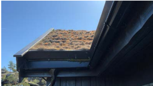
Del av taktekkning.
