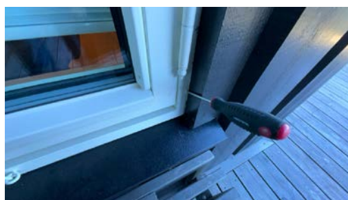
Stikkontroll på vinduer er utført.
