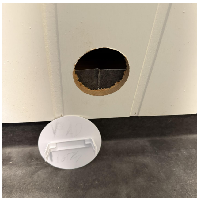
Hulltaking i vaskerom bak badekar ingen fukt målt.
