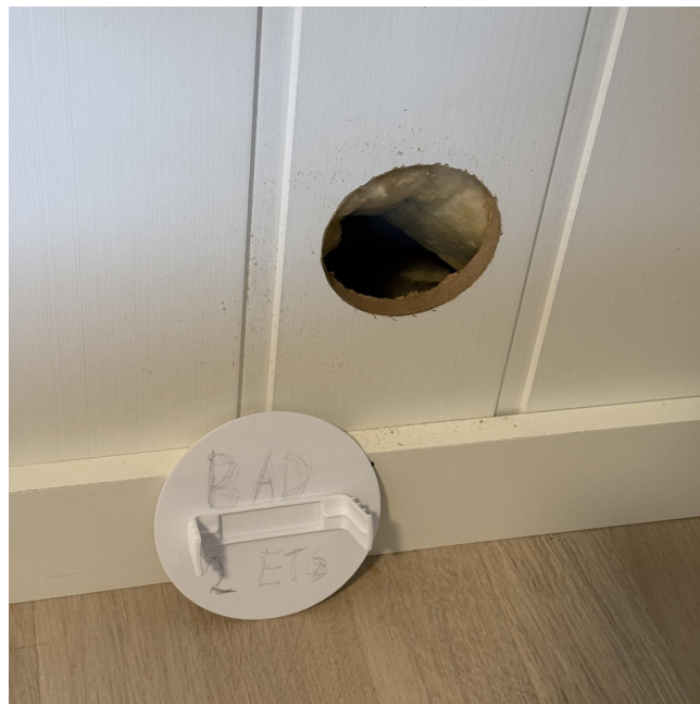
Hulltaking i stue/soverom ingen fukt målt.
