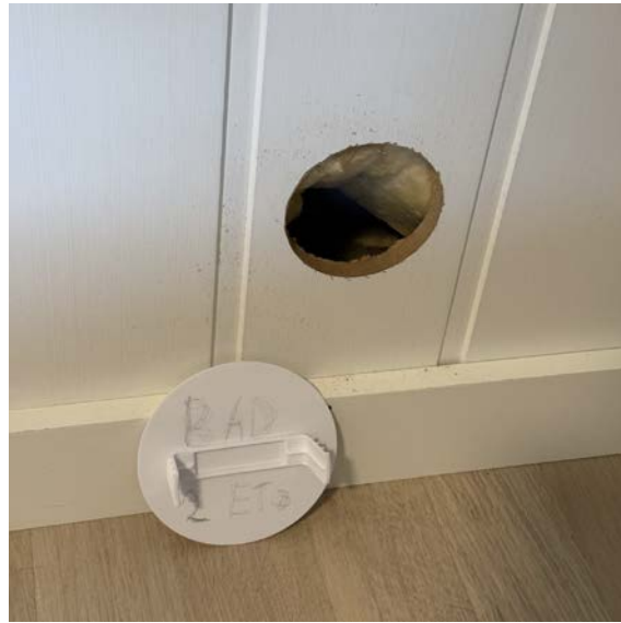
Hulltaking i stue/soverom ingen fukt målt.
