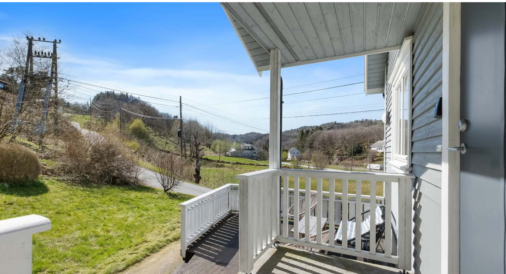
Inngangsparti har fått nytt overbygg.
