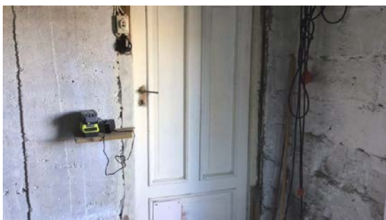
Enkel kjellerdør til garasjen
