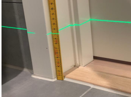
Fallforhold ca. 100 mm overkant gulv ved terskel
