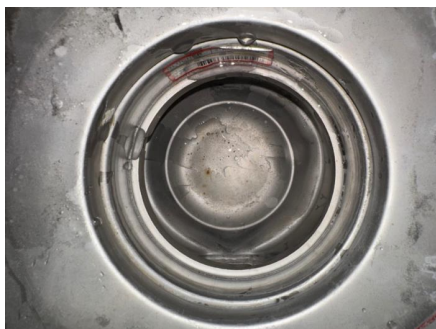
Stålsluk med vannlås i dusjsone
