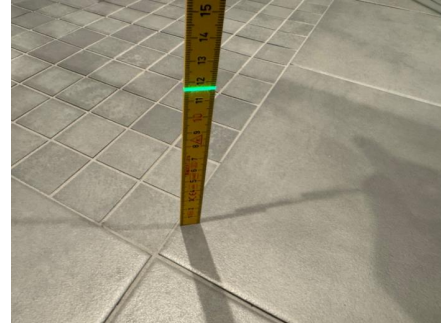
Fallforhold ca. 116 mm overkant gulv ved dusjsone
